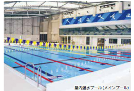
屋内温水プール(メインプール)
